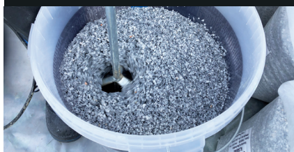
4. Vorbereiten des Granulatgemisches ALSAN 817 Bindemittel / ALSAN 887 Marmorkiesel
