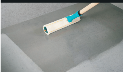
3. Aufbringen der Grundierung ALSAN 170
