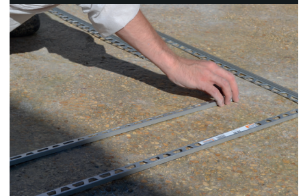
2. Aufbringen von Eingrenzungsprofilen und Treppenkantenprofilen
