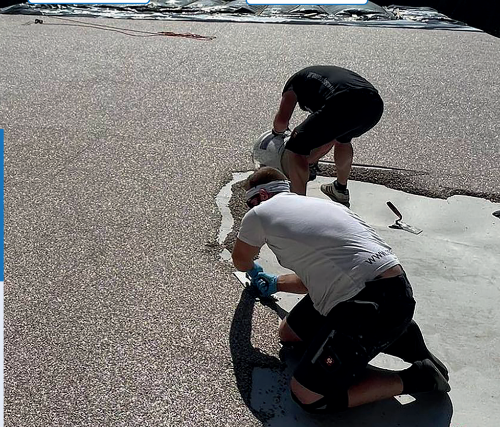
1. Vorbereitung des Untergrunds
